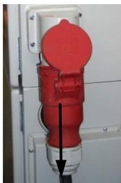
Рис. 73: Отсоединение электрокабеля
