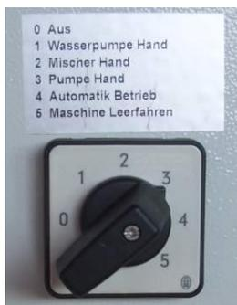
Рис. 11: Переключатель двигателя насоса
