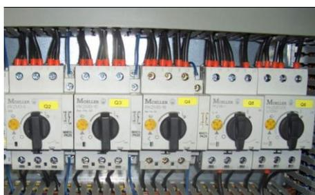
Рис. 1: Защитные реле двигателя
